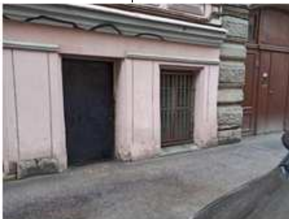
Фото 11. Отдельный вход с улицы и оконные проемы
