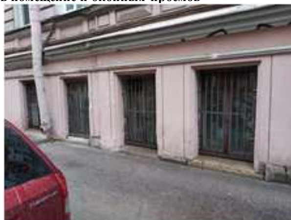
Фото 10. Оконные проемы, направленные на улицу
