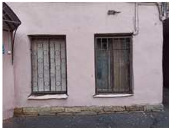
Фото 12. Оконные проемы, направленные во двор
