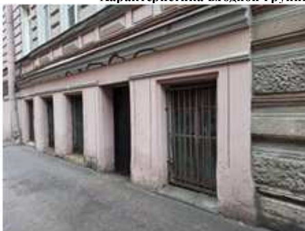
Фото 9. Отдельный вход с улицы и оконные проемы
